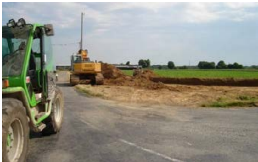
Photo 144 : Les travaux de rectification d'un virage
